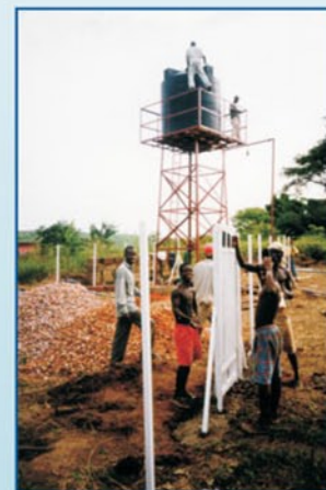
Miembros de la comunidad construyen una cerca y posicionan el tanque elevado para el SolarPedalflo™.
