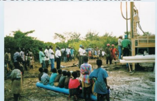
Equipos de perforación serán necesarios en las áreas que no se pueda instalar el SolarPedalflo™ en los pozos existentes. En esta foto, MWI demuestra el proceso de perforación.
