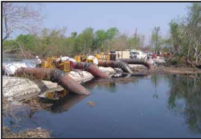
Cuatro 42"Hydraflors™, cada una con capacidad de bombeo hasta 70,000 gpm. En la estacion 15 del canal de bombeo de las aguas del Huracan Katrina.
